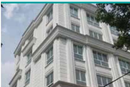
پروژه مسکونی اندرزگو، تهران
